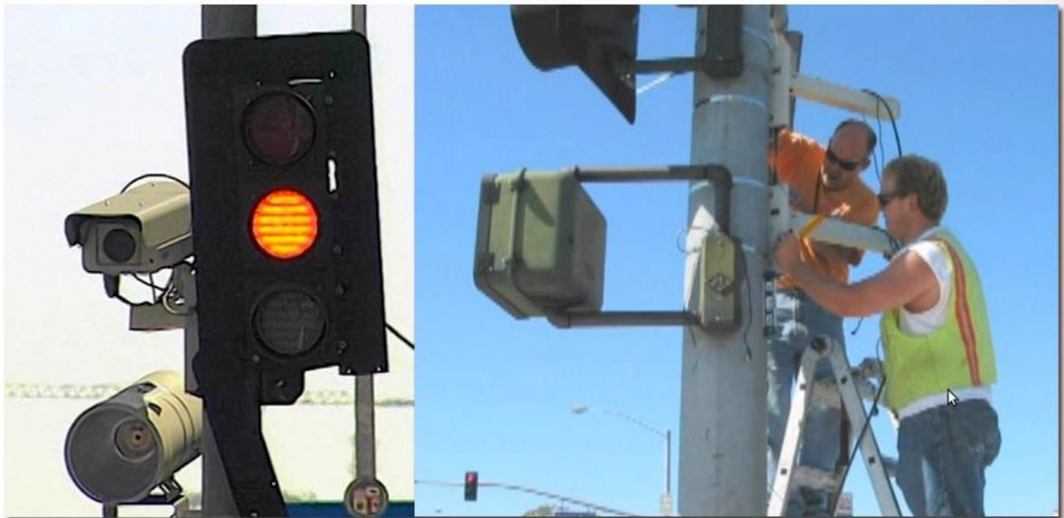
Este sistema esta desarrollado en base a un sistema micro procesado de instalación no invasiva para el área en donde se prevee su colocación. Trabaja íntimamente acoplado con el sistema de luces y el sistema electrónico del controlador del semáforo.
